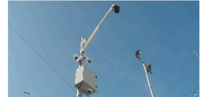
Instalación del dispositivo en un poste luz
